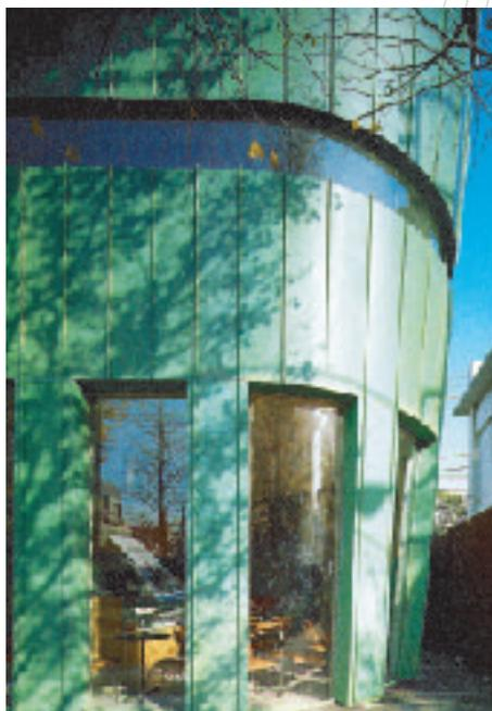
このコントラスな物体にもやはり骨と肉と皮がある。中央(エレベーターシャフト)と橋脚ともいえるほどの支柱から生えている手のひらのような梁がキャンチの床を支えその反対から支柱を引っ張るフレームがある、階段室に当たる部位がこの役目をしている、このように細部の骨組みにいたるまでこの橋脚を軸にしてバランスしているといえる。この骨組みの回りに筋の役割をもつトラスウォールをからめたセメントの肉が全体の体型を形成している。内部の壁の仕上げもモルタルである、この二重のモルタルの壁が断熱層になる。
